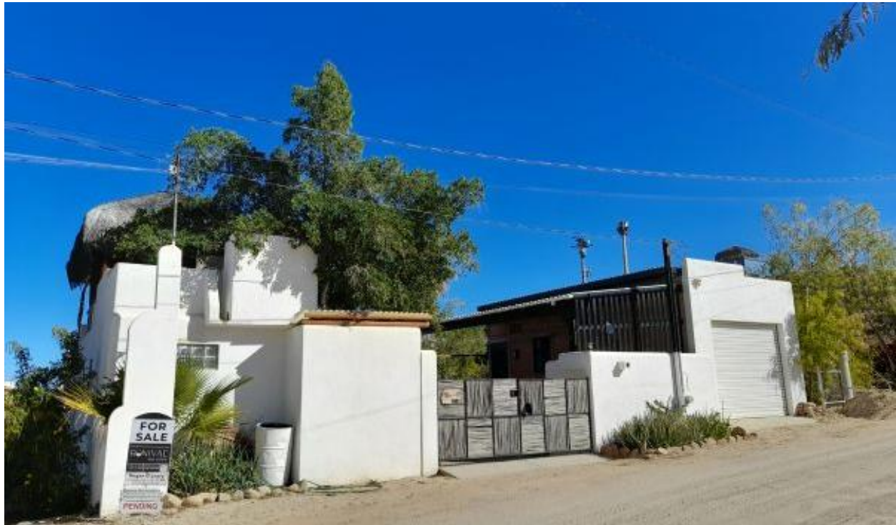
Figura 19 Ejemplo de vivienda construida sobre uso de suelo habitacional de interés medio
