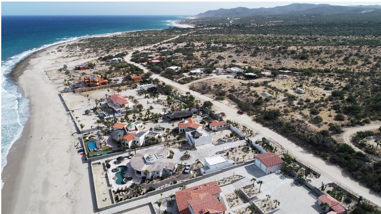
Figura 18 Ejemplo de vivienda construida sobre uso de suelo residencial turístico
