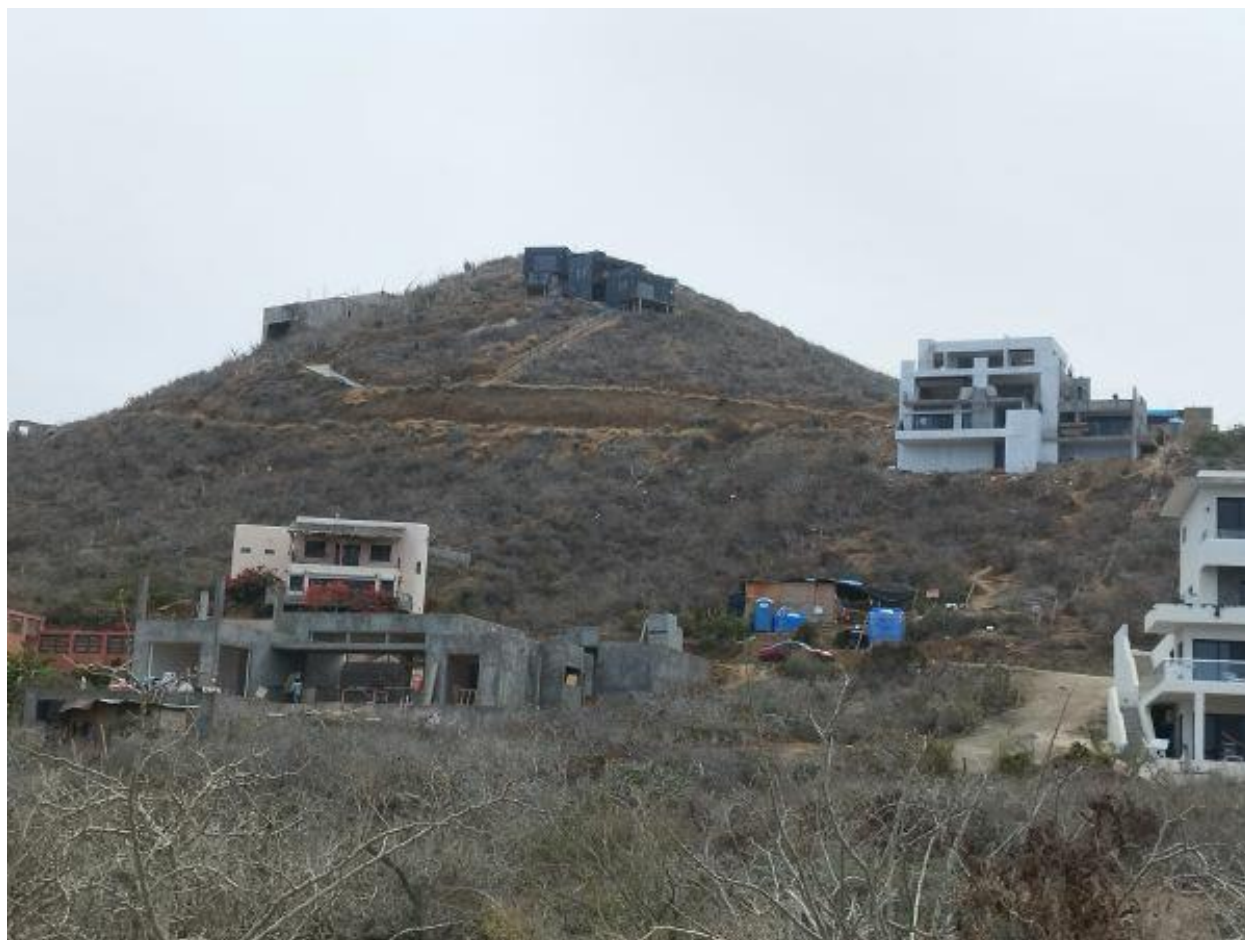
Figura 26 Construcción en pendiente en la zona de Los Cerritos.
