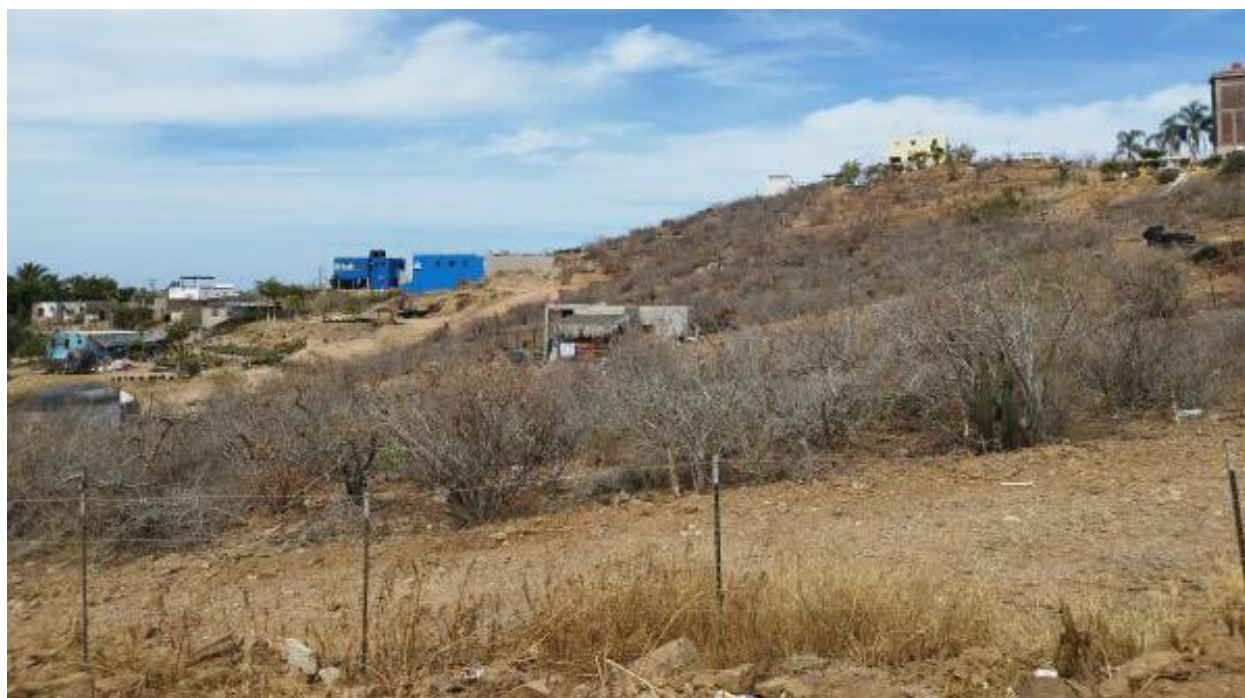
Figura 24 Vivienda en zona de Habitacional Popular en El Pescadero
