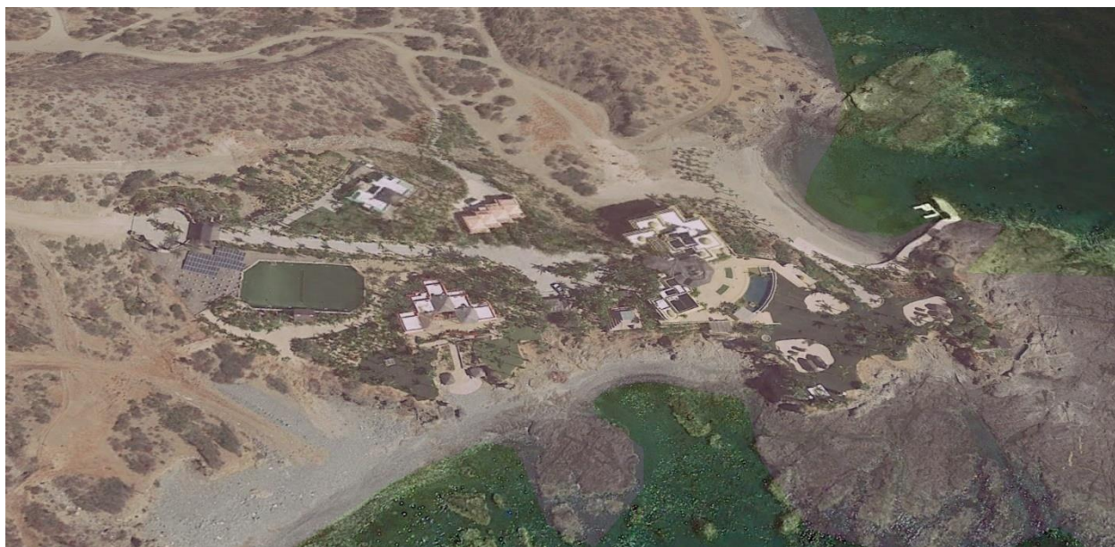
Figura 26 Vista Satelital de construcciones de alto impacto en Ensenada de Muertos
