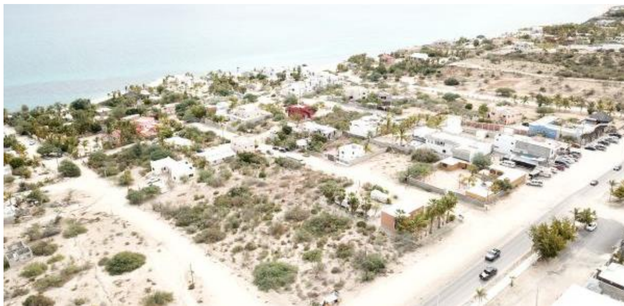
Figura 18 Ejemplo de construcción de uso turístico que no cumple con los lineamientos descritos en el PDUCP La Paz 2018
