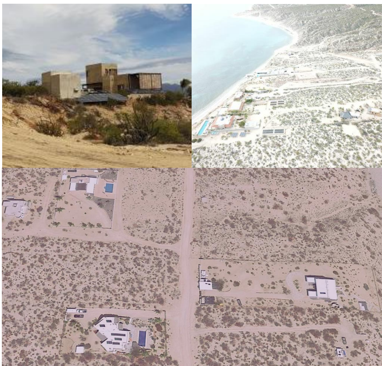
Figura 19 Tipo de construcciones predominantes en la zona norte de El Sargento
