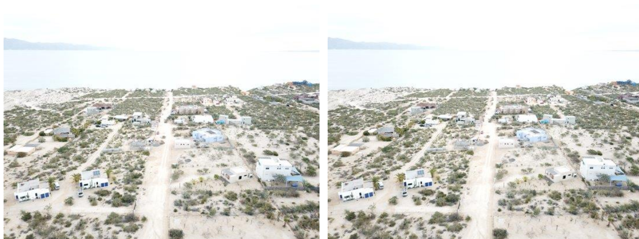
Figura 30 Ejemplo de construcción de uso Turístico que no cumple con los lineamientos descritos en el PDUCP La Paz 2018
